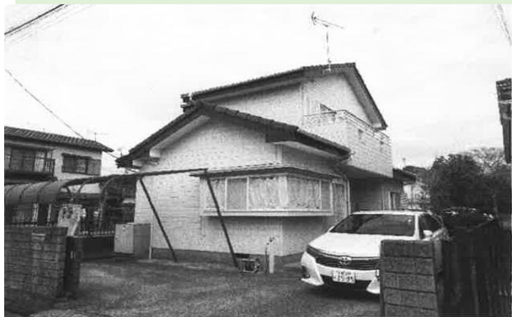
① 屋根損害 なし
